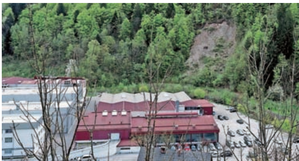
Občina Železniki in Domel se bosta letos s skupnimi močmi lotila sanacije plazov za največjim železnikarskim podjetjem. / FOTO: ANDREJ TARFILA
